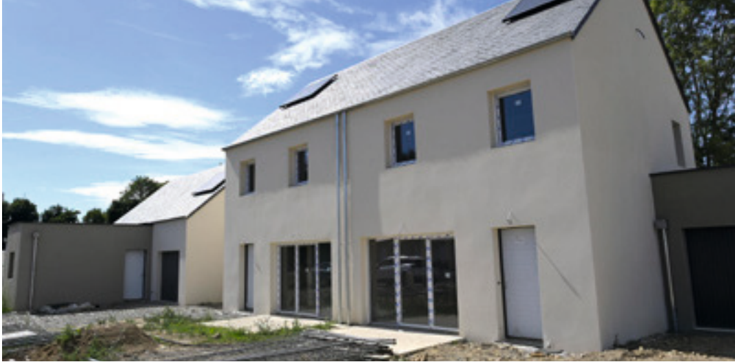
Logements en construction à La Vicomté-sur-Rance avec Terre d'Armor Habitat.
