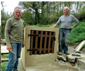
La fontaine restaurée. Récours à un mortier sable-chaux à l'extérieur
