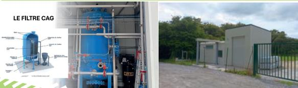
Filtre à charbon actif en grain (CAG) : matériau hautement poreux retenant les pesticides et métabolites
