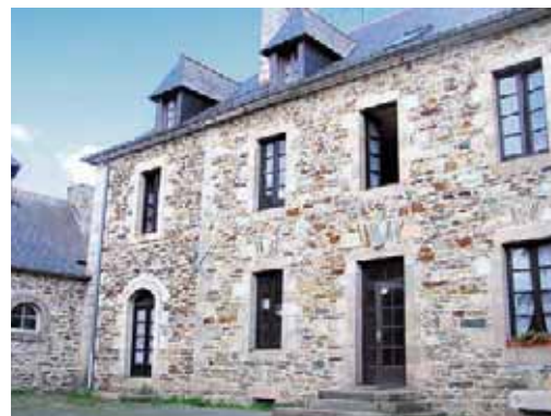
Réhabilitation du patrimoine ancien à Tréguier.
