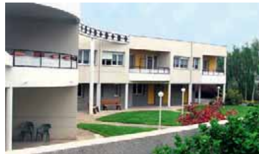
Ploumagoar, le foyer pour les personnes âgées.
