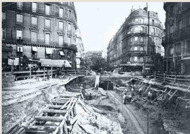
Construction de la ligne 3, rue de Rome.
