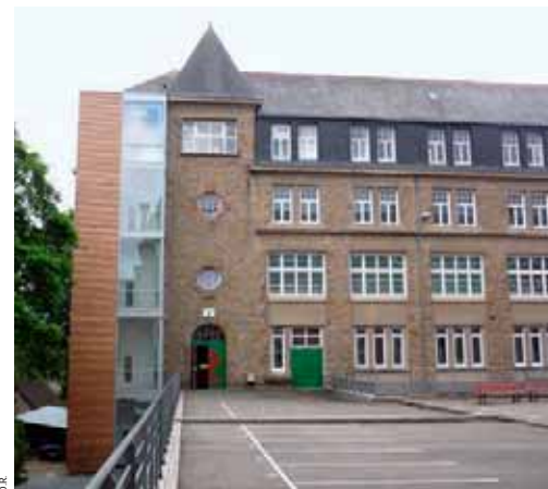
Deux ascenseurs ont été installés au collège Broussais à Dinan.
