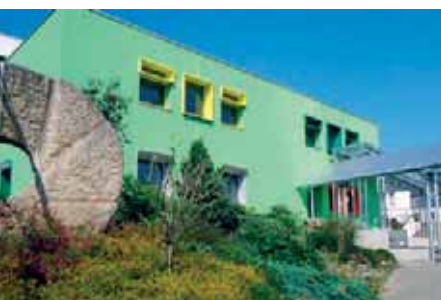
SERVICE DES BÂTIMENTS - CONSEIL GÉNÉRAL
