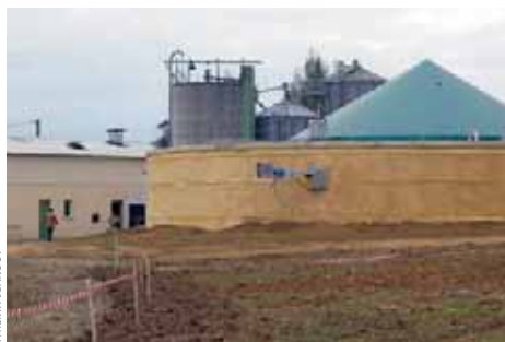
L’unité de méthanisation d’Alain Guillaume, éleveur de porcs à Plélo, a été inaugurée en 2009. C’est la première réalisation d’AEB Méthafrance.
