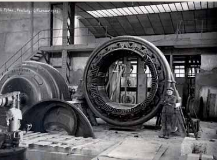
L'intérieur de l'usine hydroélectrique du barrage de Guerlédan.
