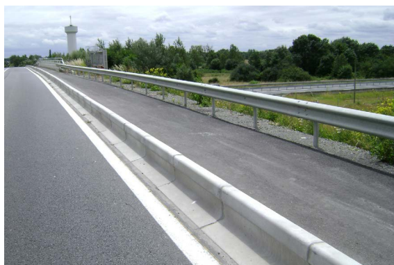
Séparatif GSS entre piste cyclable et route départementale (Bourgueil - 37)
